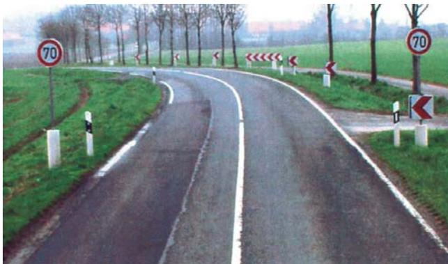
**Bild 33: Griffigkeitswechsel im Kurvenbereich durch unterschiedliche Fahrbahnbeläge und Hindernisse im Seitenraum**
