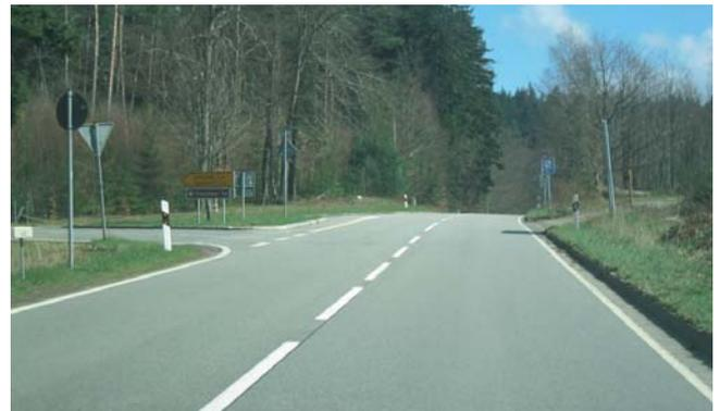
**Bild 35: Knotenpunkt mit ungünstiger Linksabbiegerführung, fehlenden Aufstellbereichen und unübersichtlichem Streckenverlauf**
