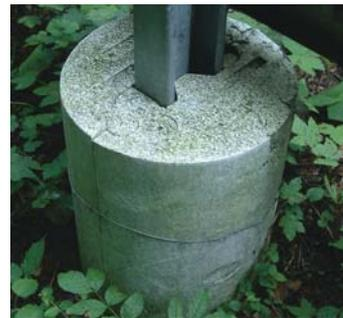
**Bild 54: Pfosten ummantelt mit Schaumstoff**
