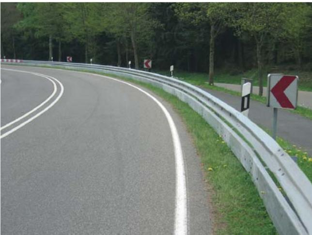
**Bild 21: Aufgelöste Richtungstafeln hinter der Schutzplanke**
