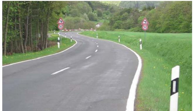
**Bild 36: Ungünstige Linienführung und zusätzlich Bodenwellen**
