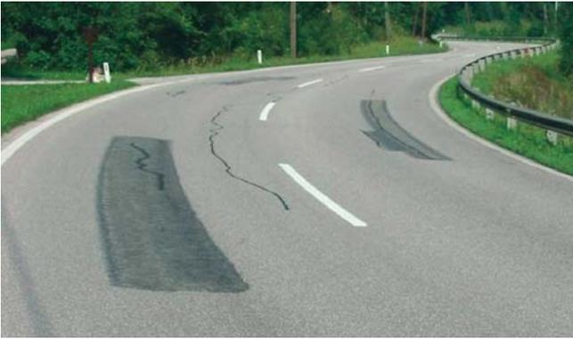
**Bild 30: Griffigkeitswechsel durch nur teilweise gefleckte Fahrbahnoberfläche in Kurven (Quelle: [15])**
