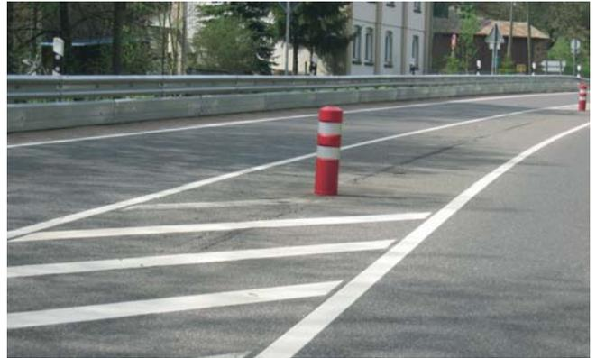
**Bild 23: Leiteinrichtung aus flexiblem Material**
