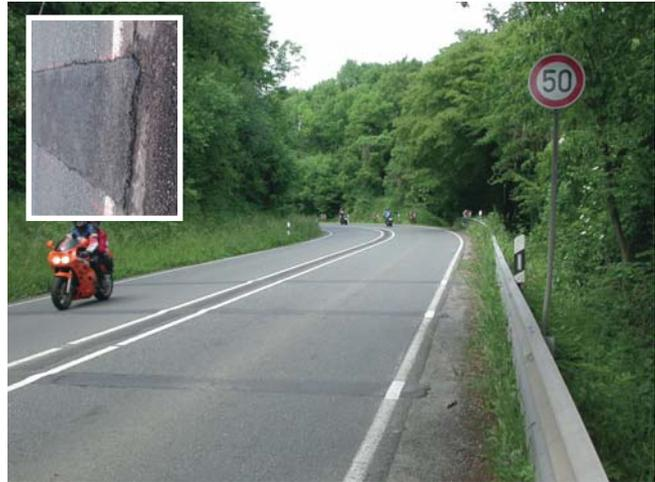
Bild 41: Verkehrssichere Geschwindigkeiten durch Rüttelstreifen [13]
