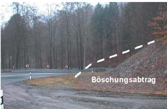
**Bild 47: Sichtfeldverbesserung durch Böschungsabtrag und Gehölzrückschnitt in der Innenkurve [12]**
