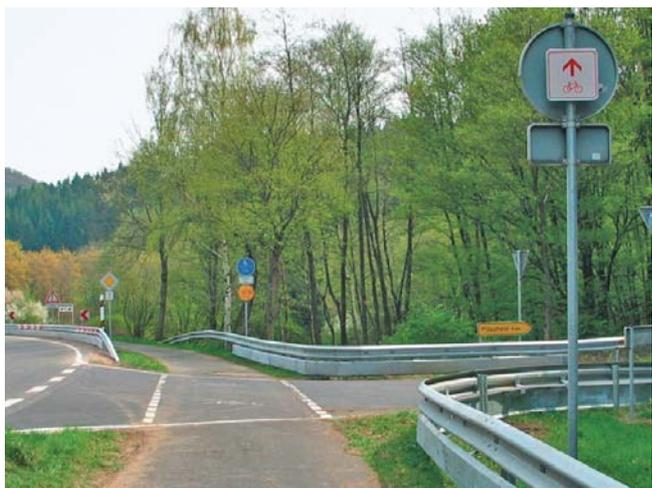
**Bild 26: Verkehrszeichen hinter Schutzeinrichtungen bei einer Einmündung am Kurvenaußenrand**
