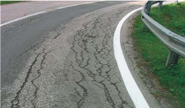
**Bild 31: Griffigkeitswechsel durch Risse im Fahrbahnbelag (Quelle: [15])**
