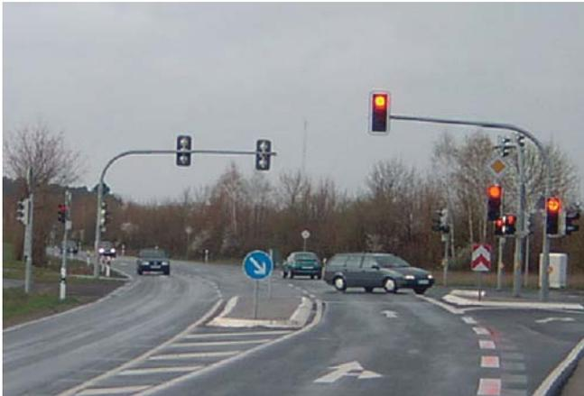
Bild 39: Fahrbahnteiler als Maßnahme gegen Überholmanöver im Knotenpunkt mit Lichtsignalanlage
