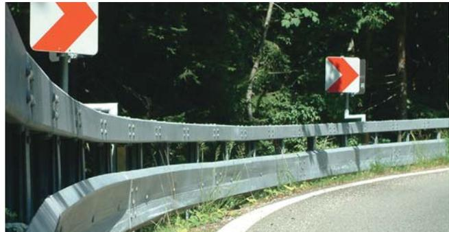
**Bild 53: Schweizer Kastenprofil mit Unterfahrschutz**
