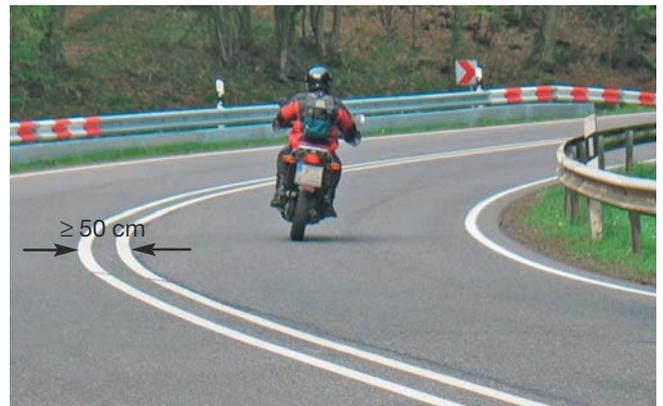
Bild 16: Aufweitung der Fahrstreifenbegrenzung
