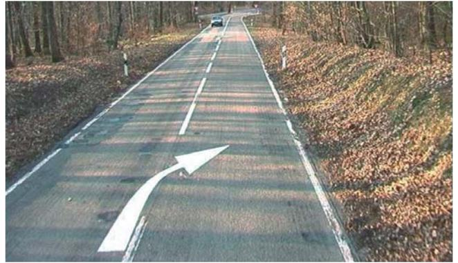
**Bild 34: Überdimensionierte Vorankündigungspfeile erzeugen Griffigkeitswechsel**
