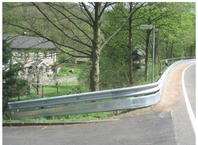
Bild 44: Schutzplanke mit Unterfahrschutz vor Geländer, in den Einmündungsbereich gezogen [14]
