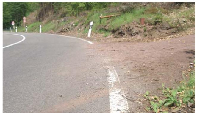
**Bild 37: Unzureichende Befestigung im Einmündungsbereich eines Feldweges**
