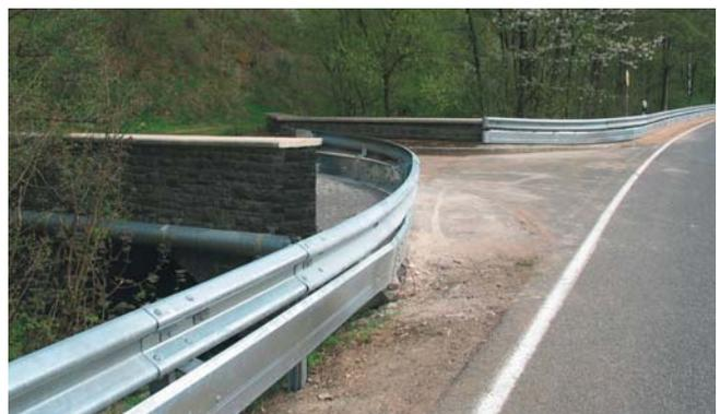
**Bild 50: Gesicherte Mauern an der Kurvenaußenseite [14]**
