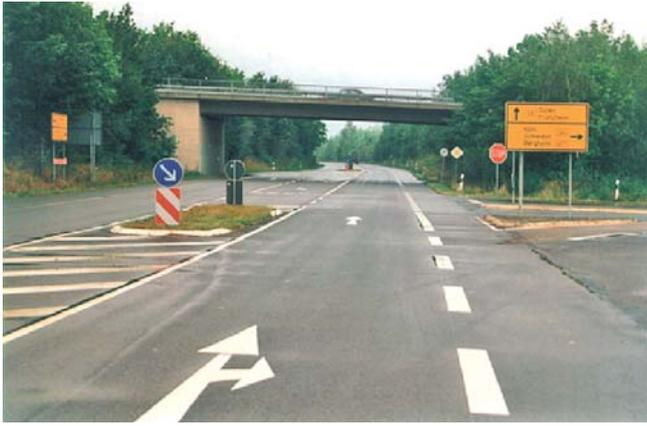
Bild 38: Fahrbahnteiler als Maßnahme gegen Überholmanöver im Knotenpunkt ohne Lichtsignalanlage
