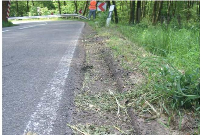
**Bild 48: Verschmutzungsgefahr durch ausgefahrenes Bankett**
