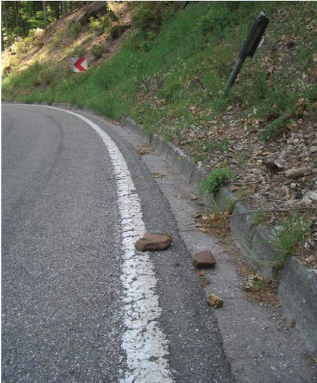
**Bild 45: Böschungssicherung unzureichend**
