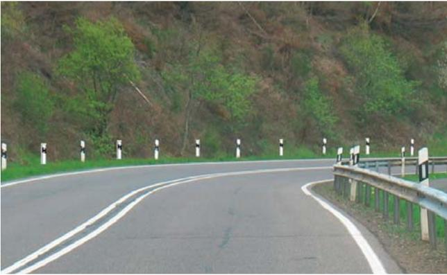
**Bild 20: Verdichtet gestellte Leitpfosten**
