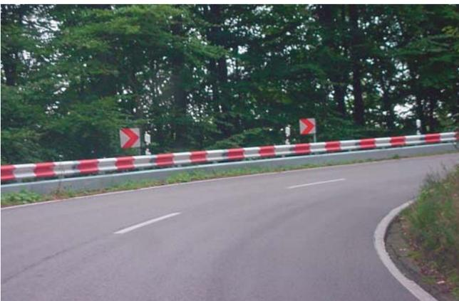
**Bild 22: Leitprofile in der Schutzplanke**
